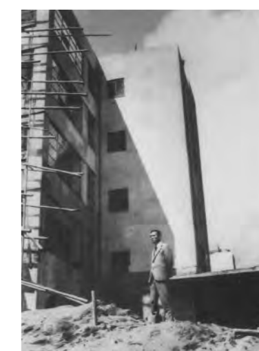
建設中のブリヂストンタイヤ(株)久留米工場
